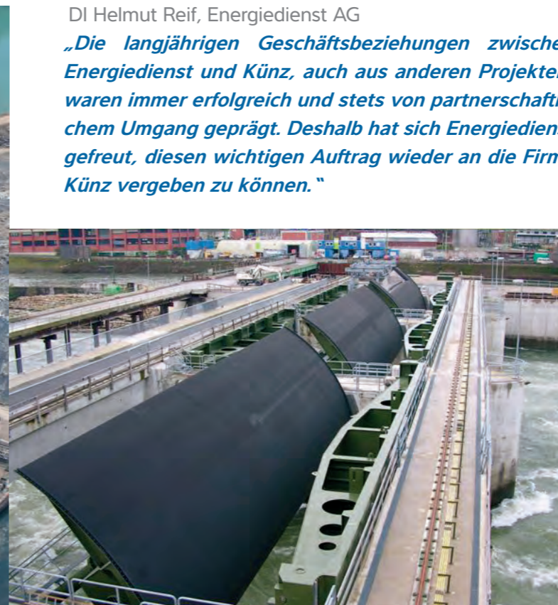
Segmente und Dammbalken
