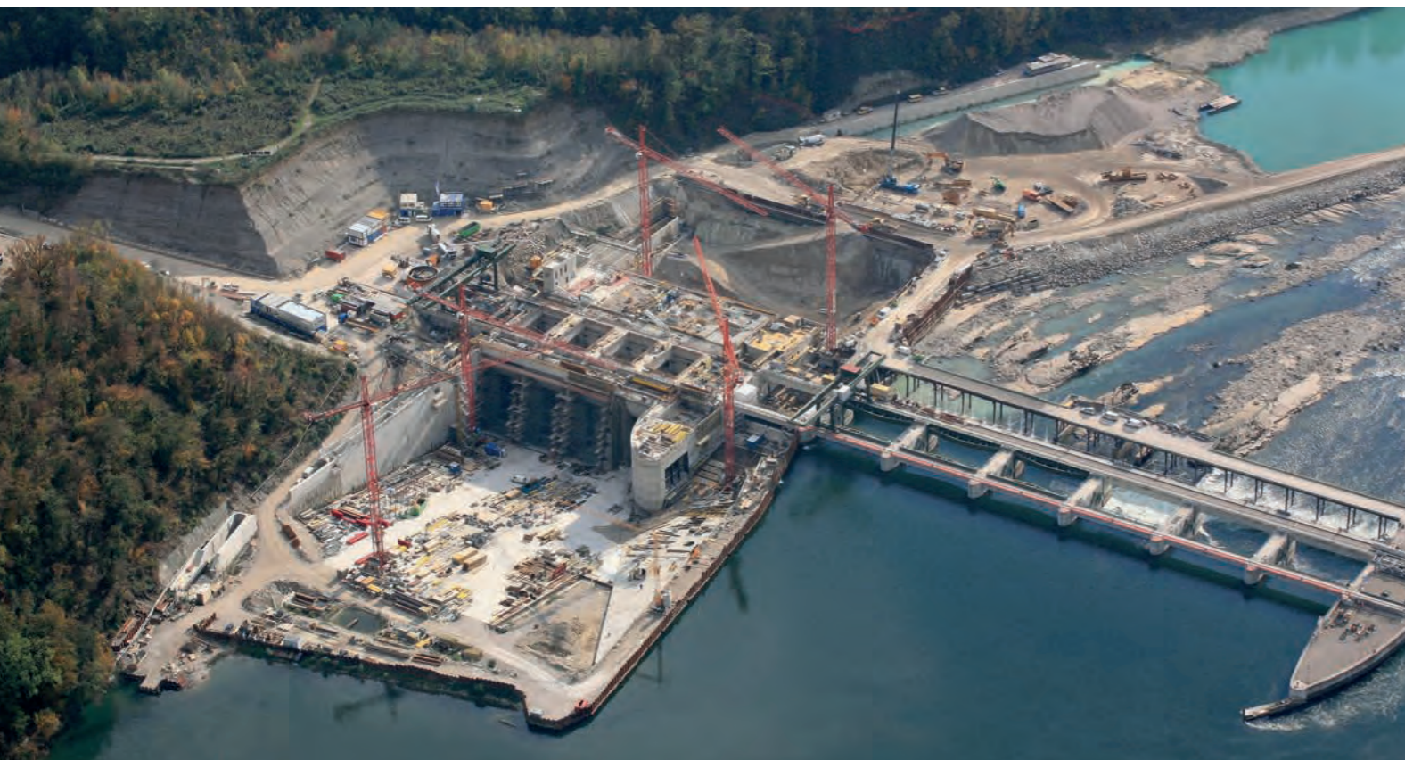
Eingerichtete Seitenschilder vor dem Betonieren
