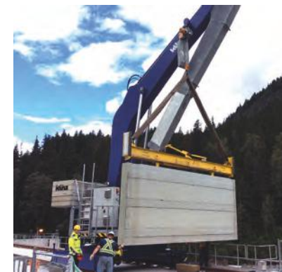
Dammbalken setzen mit hydraulischer Rechenreinigungsmaschine
