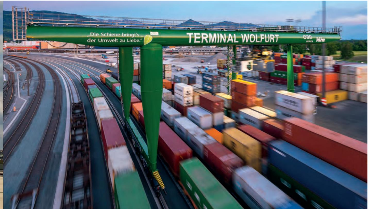
Intermodal Krane am Terminal in Wolfurt mit Aerodynamischem Portal Design
